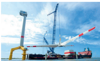
港湾での設備組み立て
