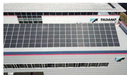
太陽光パネルの設置(技術研究所)
