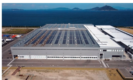
太陽光パネルの設置(香西工場)
