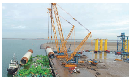
港湾で風車の部材積込を行うクローラークレーン
