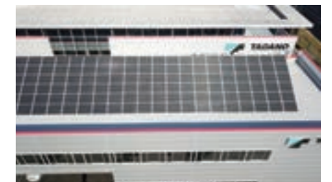
太陽光パネルの設置(技術研究所)
