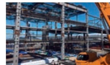
建設中のパワートレイン試験棟
