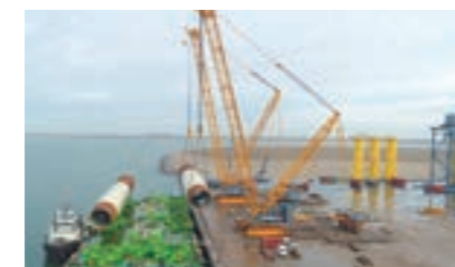
港湾で風車の部材積込を行うクローラークレーン
