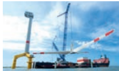
港湾での設備組み立て
