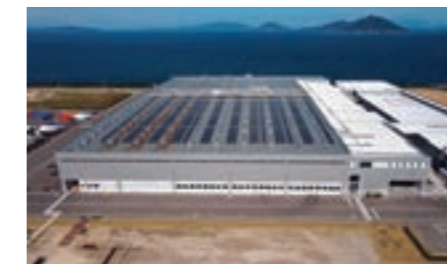
太陽光パネルの設置(香西工場)
