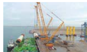
港湾で風車の部材横搬を行うクローラークレーン
