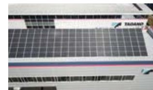
太陽光パネルの設置(技術研究所)
