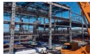
建設中のパワートレイン試験棟
