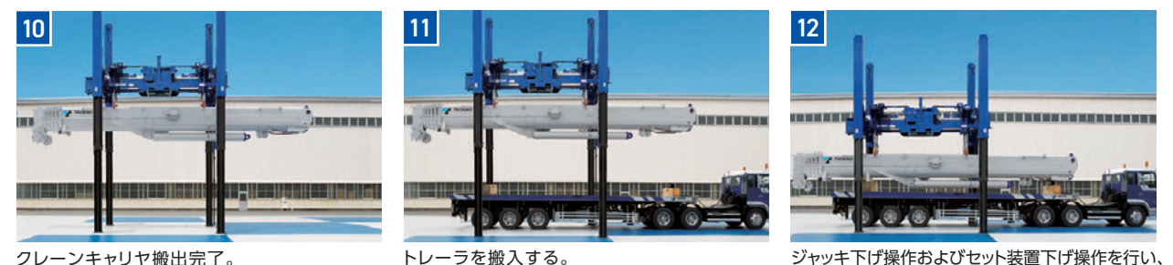
クレーンキャリア搬出完了。
