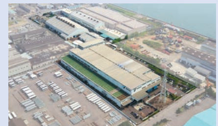
多度津工場 [香川県多度津町] (カーゴクレーンの製造)
