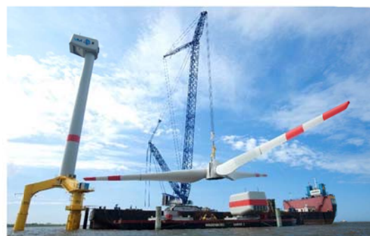
洋上で風車のブレード据付を行うクローラークレーン
