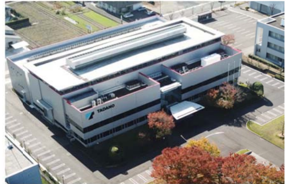
2020年に増築を完了した技術研究所(香川県高松市)
