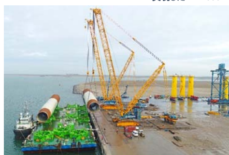
港湾で風車の部材積込を行うCC
