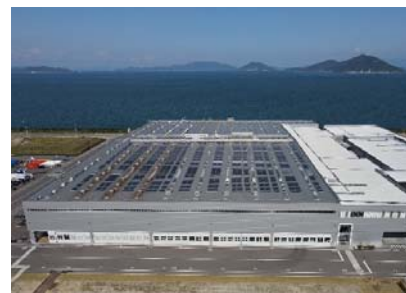
香西工場の太陽光発電設備
