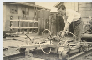
軌条枕木位置修正機
