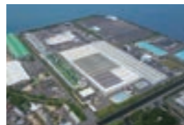
太陽光パネルの設置(志度工場)
