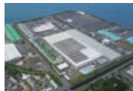
太陽光パネルの設置(志度工場)
