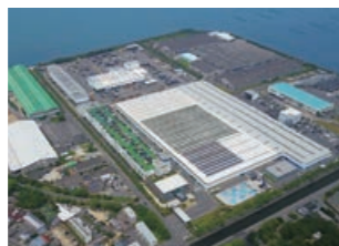
太陽光パネルの設置(志度工場)
